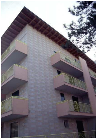
Edificio residenziale pluripiano, blocchi fonoisolanti portanti. Rivestimento acustico in blocchi facciavista colorati
